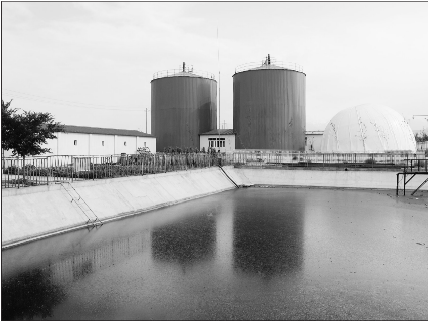
图为新疆维吾尔自治区吉木萨尔县三台镇羊圈台子村沼气工程项目。 陈雪莲摄
