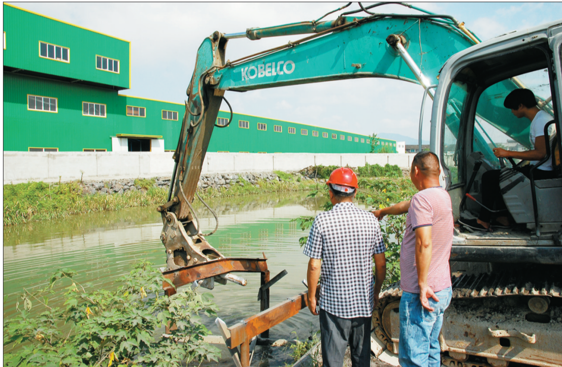
浙江省台州市椒江区近日集中对辖区永宁河沿线的小码头、土窖、养猪场等10处违建物进行强制拆除,全力推进“三改一拆”,强化“五水共治”,保护河道水环境。 人民图片网供图
