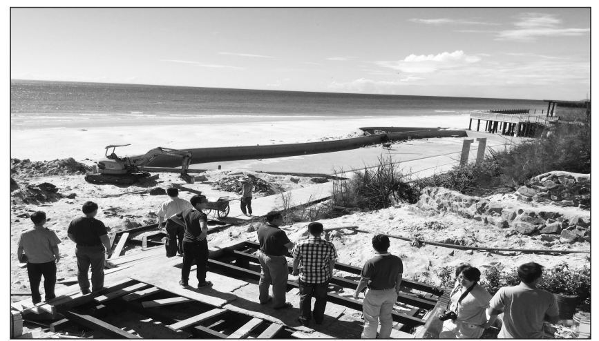
图为检查组现场拆除文昌富力月亮湾的海边在建游泳池。
