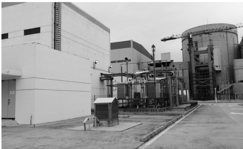
图为福建省宁德核电站。
