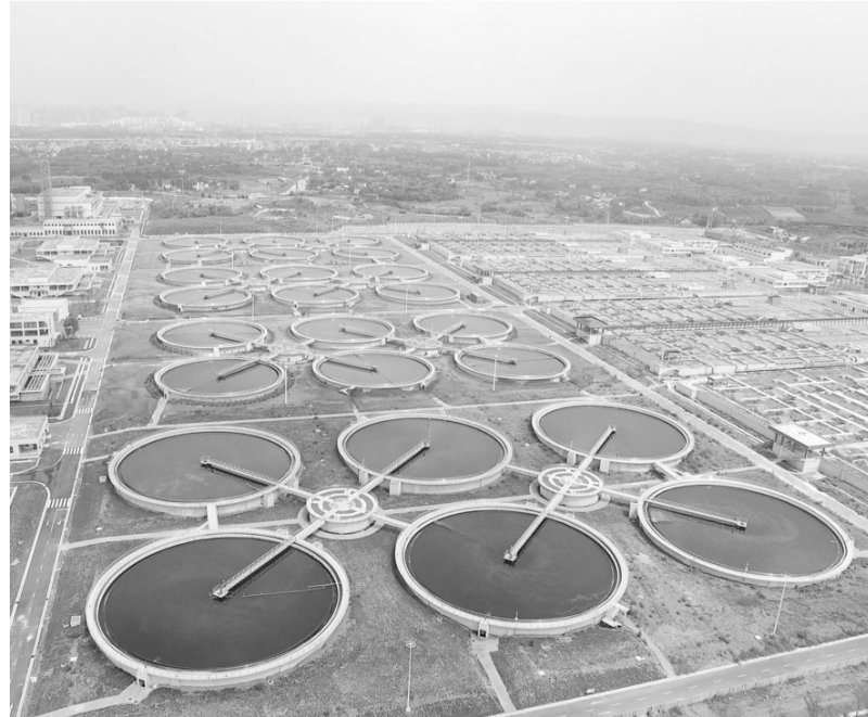
图为成都市新建污水处理厂。
