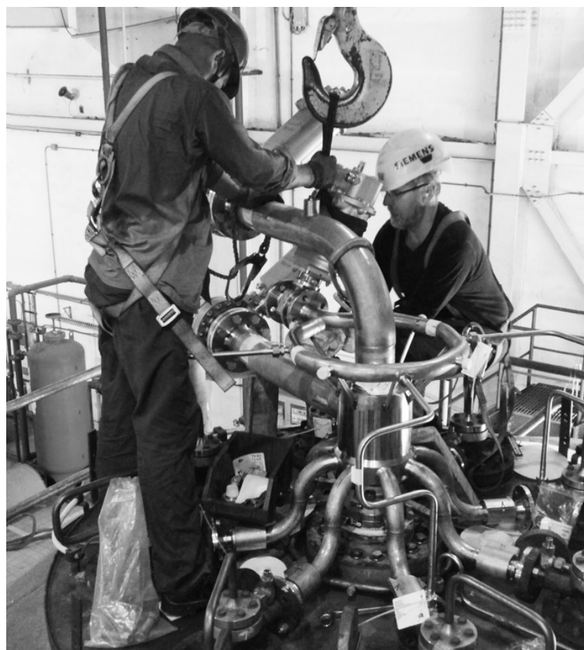
西门子专家在电厂现场安装低氮部分管阀与阀门。
