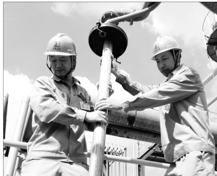
齐鲁石化塑料厂把好物料进厂、生产、销售每一道关,注重全过程清洁生产。针对苯乙烯副产品装车过程易挥发的特点,齐鲁石化塑料厂通过技术改造,实现了挥发气全过程回收。全密闭的装车操作,彻底消除了物料挥发产生的异味。 图为在齐鲁石化塑料厂苯乙烯罐区装车现场,工作人员正准备装车。 王敬华 摄
