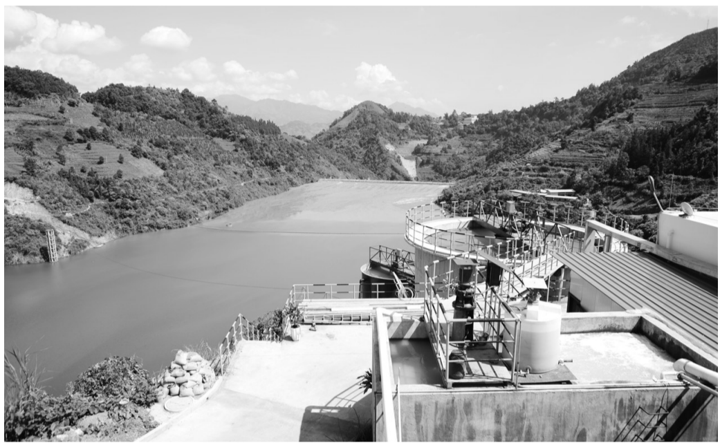
图为马关县都龙矿区万龙山尾矿库旁,正在满负荷运行的云南华联锌铜公司尾矿废水中和氟化物治理技术示范工程。 蒋朝晖摄
