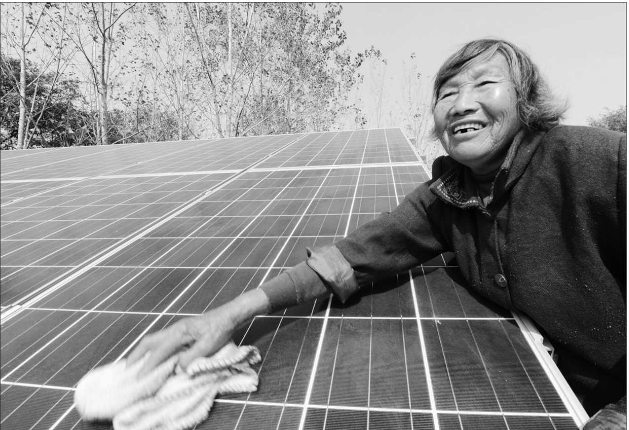
安徽省亳州市利辛县大力推广光伏发电,并计划今后在全县范围内选择5000个贫困户,每户建设3KW分布式光伏发电系统。收回成本后,预计每户可实现年发电收入3000多元。图为一位老人正在清理自家的户用分布式光伏电站的太阳能多晶硅板。
