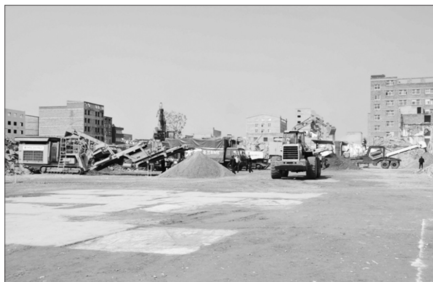
郑州鼎盛公司建设、运营管理的高新区建筑垃圾消纳场,现阶段日平均消纳建筑垃圾4000立方米。
