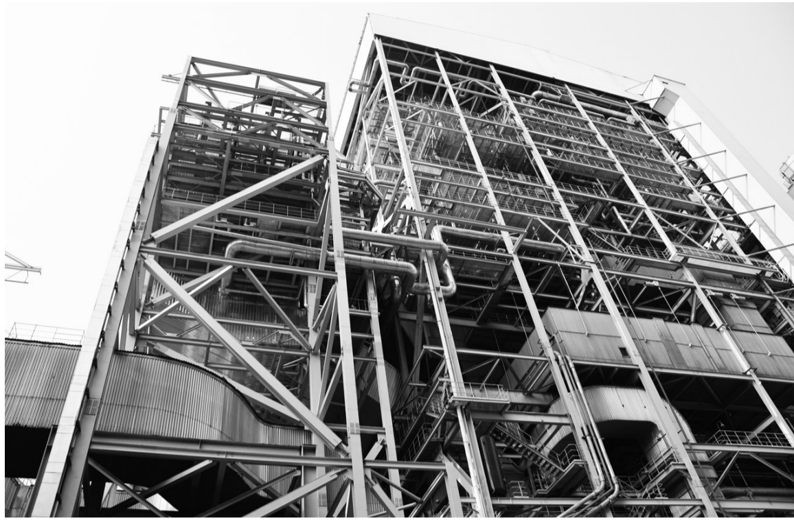
金湾发电公司3、4号机组装机容量都是60万千瓦,此前,由于电网调峰,机组发电负荷低于40万千瓦的时候,脱硝装置就自动退出。现在,只要发电负荷不低于25万千瓦,都能保障脱硝设施正常运行。
