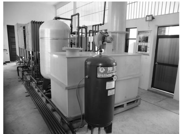
2008年以来,普洱市新建成投运9个垃圾处理项目,设计日处理能力557吨,完成投资2.96亿元。图为建成投运、采用两级膜管式反渗透(DTRO)处理工艺的宁洱县垃圾处理场渗滤液处理站主要设备。 蒋朝晖摄
