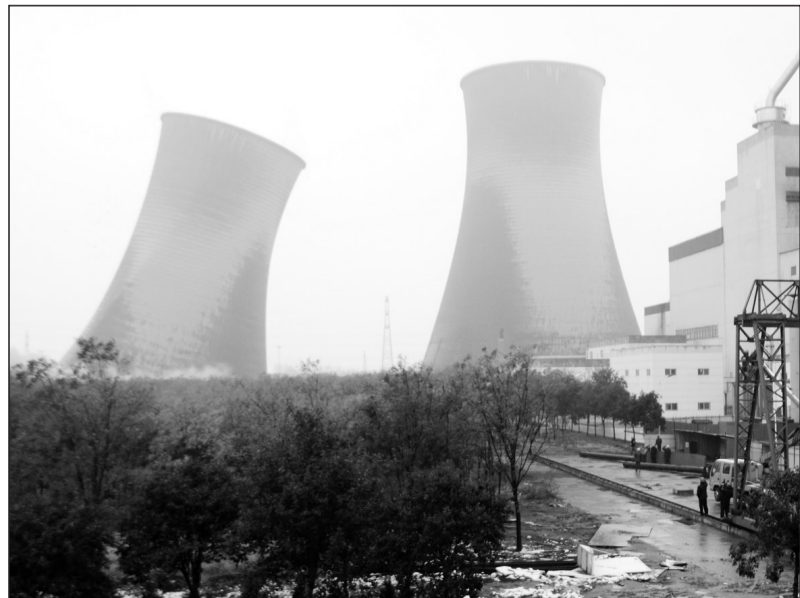
为积极响应国家节能减排、实行绿色发展政策,支持京津冀大气污染防治行动,近日,河北建投集团兴泰发电公司对8#、9#机组冷却塔实施爆破拆除。此举标志着公司全部220MW小火电机组彻底告别历史舞台。 李柱峰 周迎久摄
