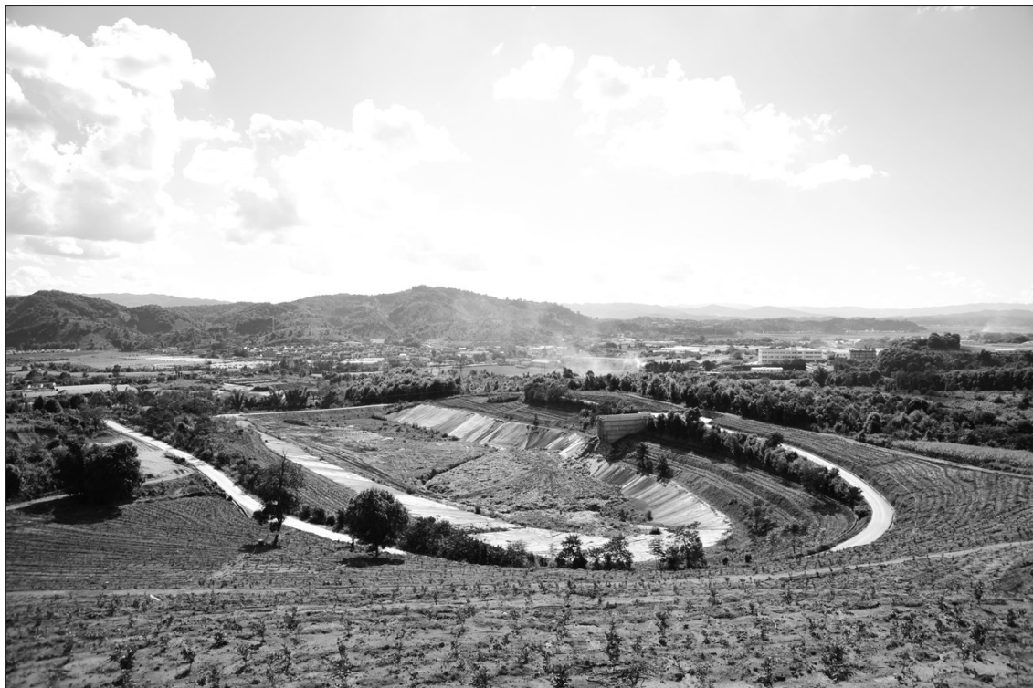
图为实施冰糖橙种植项目的云南省西双版纳傣族自治州勐海县垃圾填埋场。蒋朝晖摄
