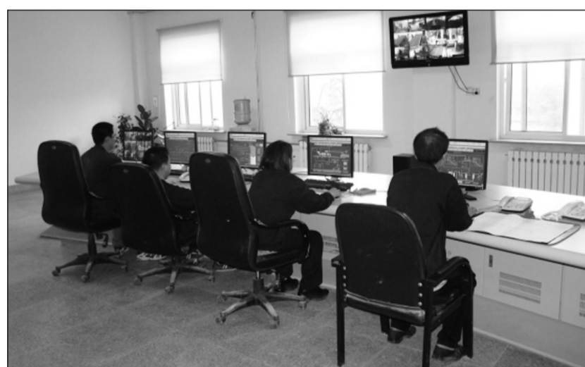
辽宁能港发电有限公司自动化脱硫控制中心。
