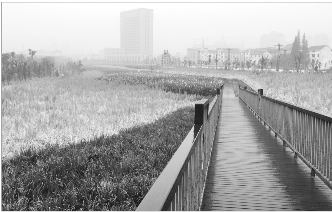
浙江省东阳市生态湿地公园日处理6万吨污水,同时将治污与园林景观结合,为市民提供休闲好去处。 晏利扬摄
