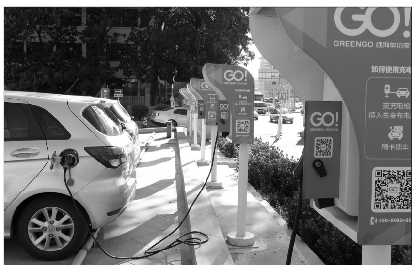
北京市发改委日前发布了《关于北京市新能源小客车公用充电设施投资建设管理办法(试行)》,规定新建居住类建筑将按照停车位100%配建充电设施或预留充电设施位置。2017年,北京市将实现平均每5公里一个充电网点。 本报记者邓佳摄
