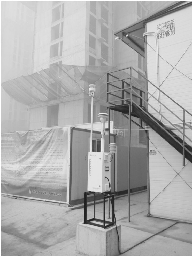
网格化监测系统安装的监测仪器,包括颗粒物微型监测仪、小型六参数(PM 10 、PM 2.5 、SO 2 、NO 2 、CO、O 3 )空气质量监测仪、小型颗粒物监测仪和微型五参数(PM 10 或PM 2.5 、SO 2 、NO 2 、CO、O 3 )空气质量监测仪。监测仪产品已形成系列化,可根据不同监测站的需要灵活选择、组合。
