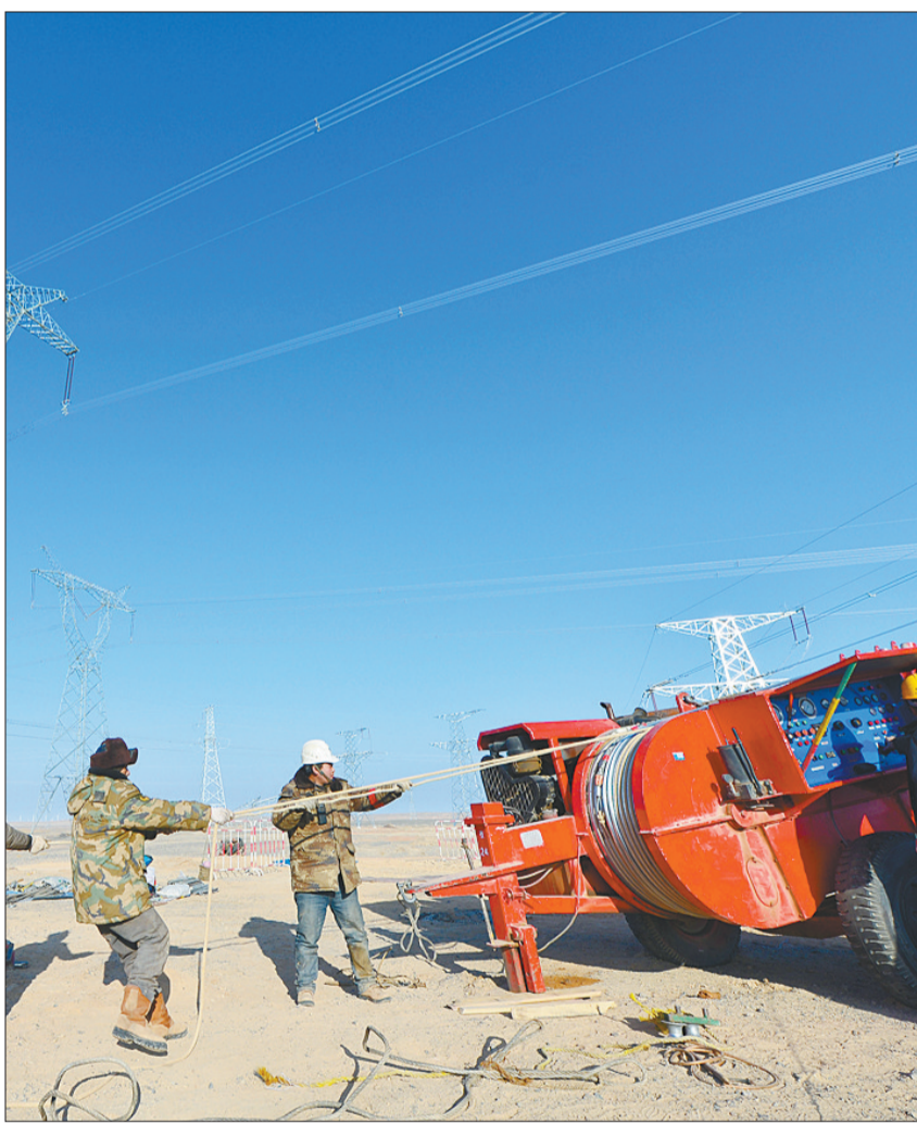
连日来,国家电网新疆电力公司哈密供电公司加快风电、光伏配套送出电网工程建设,打通“疆电外送”通道,解决清洁能源消纳难题。图为哈密供电公司工作人员在工程现场架线。
