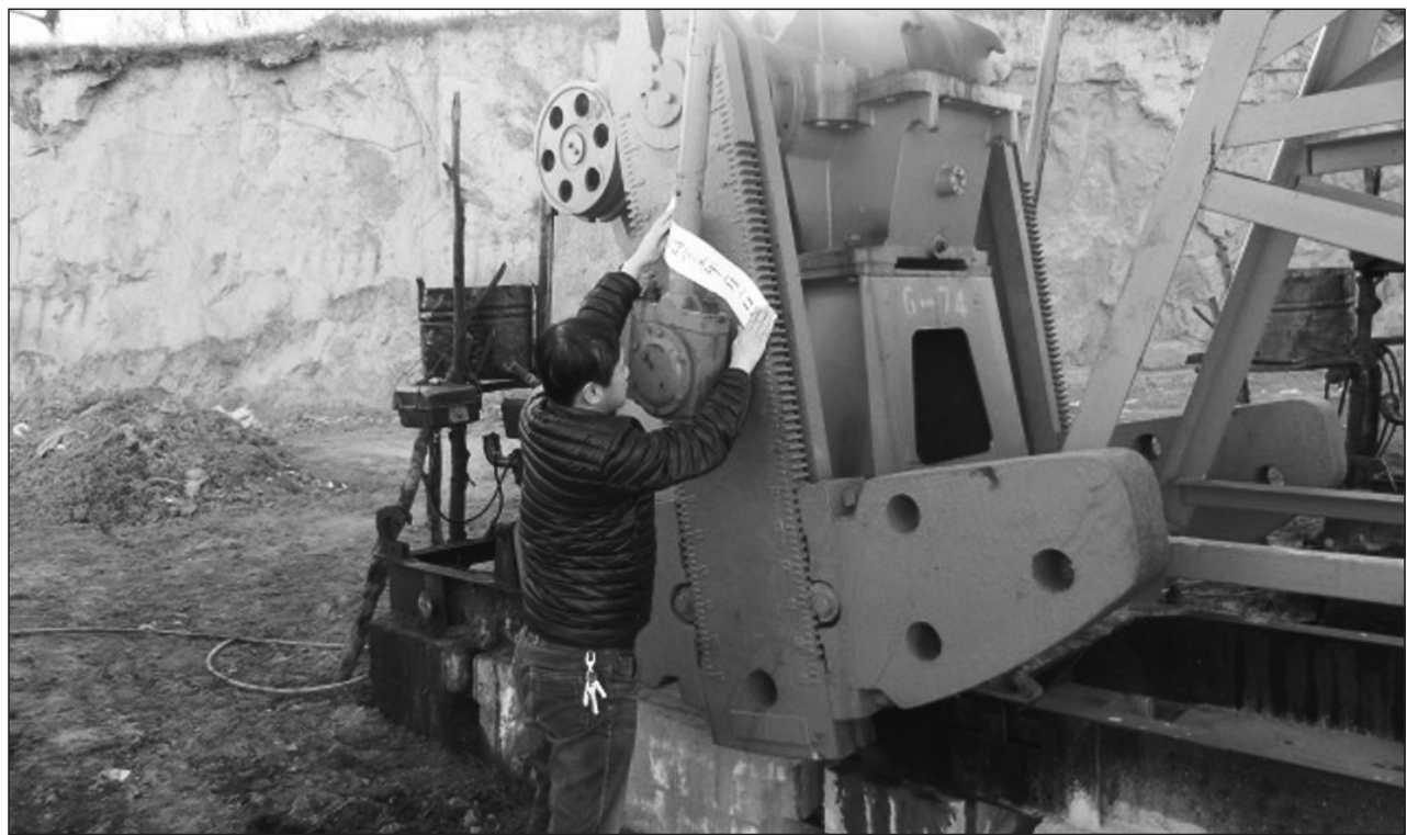
陕西省富县环保局日前在全县范围内开展了环境安全隐患排查工作。本次排查重点检查县城内涉油涉煤企业、工业园区、畜禽养殖、电磁辐射及所有建设项目。图为工作人员正在对存在问题的油井进行封停。
