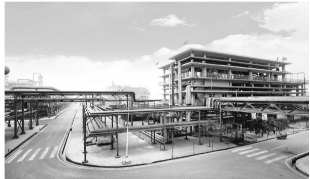
福华集团氯甲烷回收车间。
