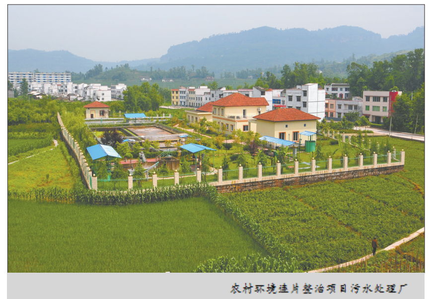
农村环境连片整治项目污水处理厂
