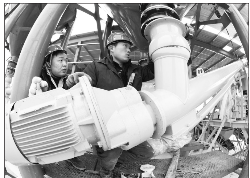
湖北省襄阳市市政工程总公司近日从美国引进了贝赛尔混凝土制品生产线,以破碎筛分后的建筑垃圾、水泥为主要原料,掺加少量沙和粉煤灰生产标准生砖或混凝土砌块。 安富斌摄/人民网供图
