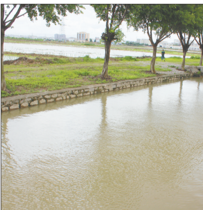
整治后的华美沟渠。
