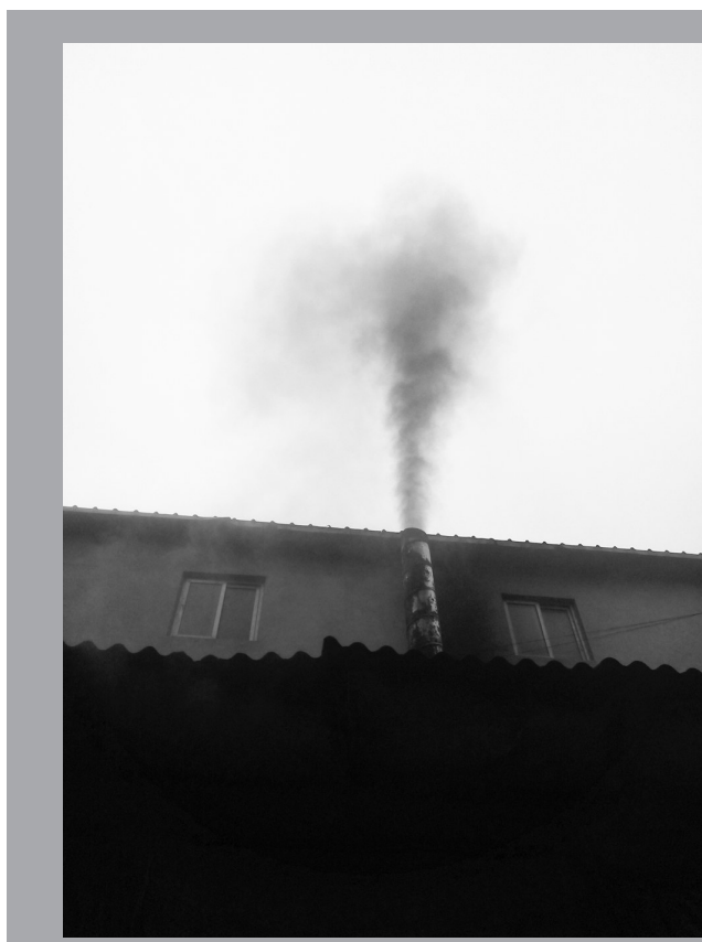
在建新庄的一个大院里,自烧锅炉房的烟囱冒出了浓烟,由于长时间的熏烤,紧挨烟囱的墙壁也变黑了。
