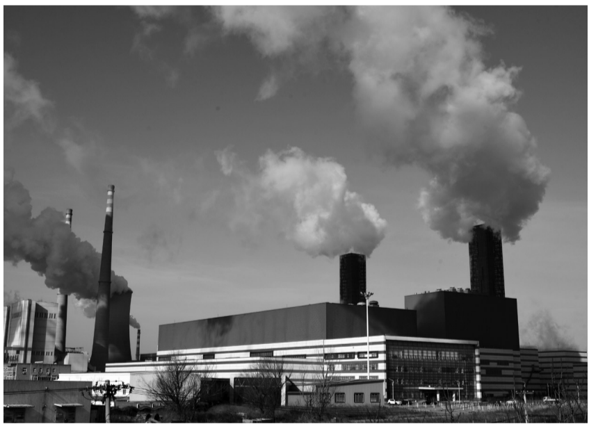
寒潮近日席卷全国,位于北京市朝阳区金盏乡马各庄的东北热电中心加大马力供暖。东北热电中心建设有两台燃气热电联产机组,其所属集团为提高燃料能源利用率,建设了大规模的余热利用回收工程应用项目,除采用高效低氮燃烧器之外,还加装了烟气脱硝装置。
