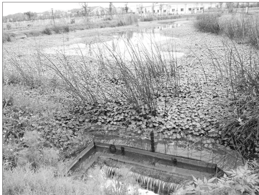
图为洋湖再生水厂的出水口。
