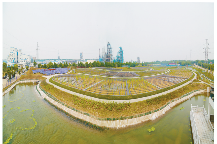
常熟市建成江苏省目前唯一的工业污水处理厂尾水生态湿地处理中心
