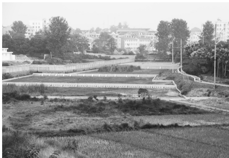
图为武汉市黄陂区木兰乡集镇生活污水湿地处理系统。张雷摄
