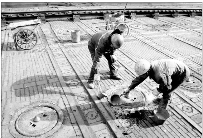
安徽省马鞍山市马钢焦化公司积极提升安全环保工作水平,根据生产工艺的特点,加大环境整治力度,杜绝跑、冒、滴、漏等现象发生。图为维护人员正在焦炉台上对装煤孔进行密封。
