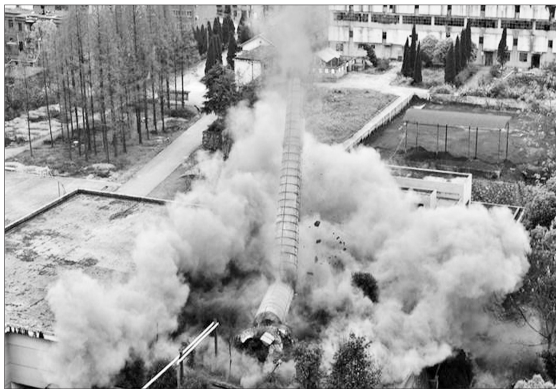
为改善空气质量,湖北省咸宁市福人金身药业公司一根34米高的锅炉烟囱近日被成功爆破拆除。至此,咸宁市中心城区燃煤锅炉烟囱已全部拆除完毕。 夏正锋摄
