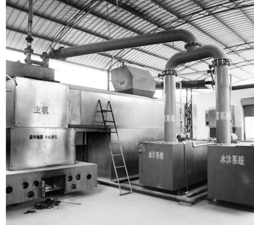
图为云南省在推进农村环境综合整治中首座建成且已稳定运行两年的芒市芒芒垃圾热解处理站。垃圾热解工艺具有占地小、一次点火无需助燃、能耗低的特点,烟气可达标排放,垃圾处理后可减量95%以上。 蒋朝晖摄
