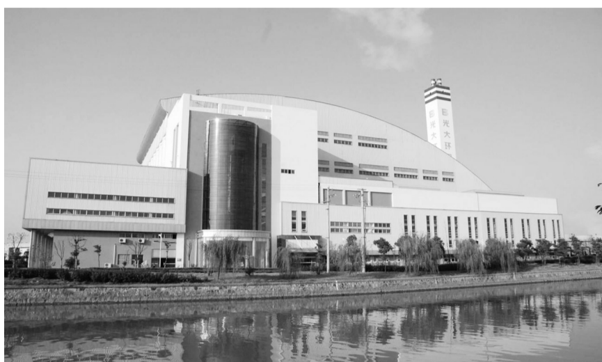
图为江苏省江阴生活垃圾焚烧发电项目。 资料图片
