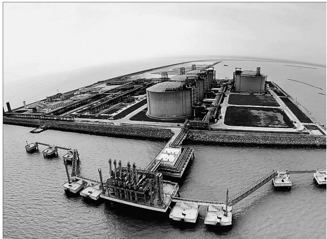
西南地区首个LNG项目,中国石化天然气分公司北海LNG接收站近日正式进入商业运营。项目位于广西壮族自治区北部湾经济区——北海市铁山港区南港池石化作业区,一期工程年接转能力300万吨,相当于40亿立方米天然气,可供2200万户家庭用气,广西及粤西地区将率先受益。 陈鸣启摄
