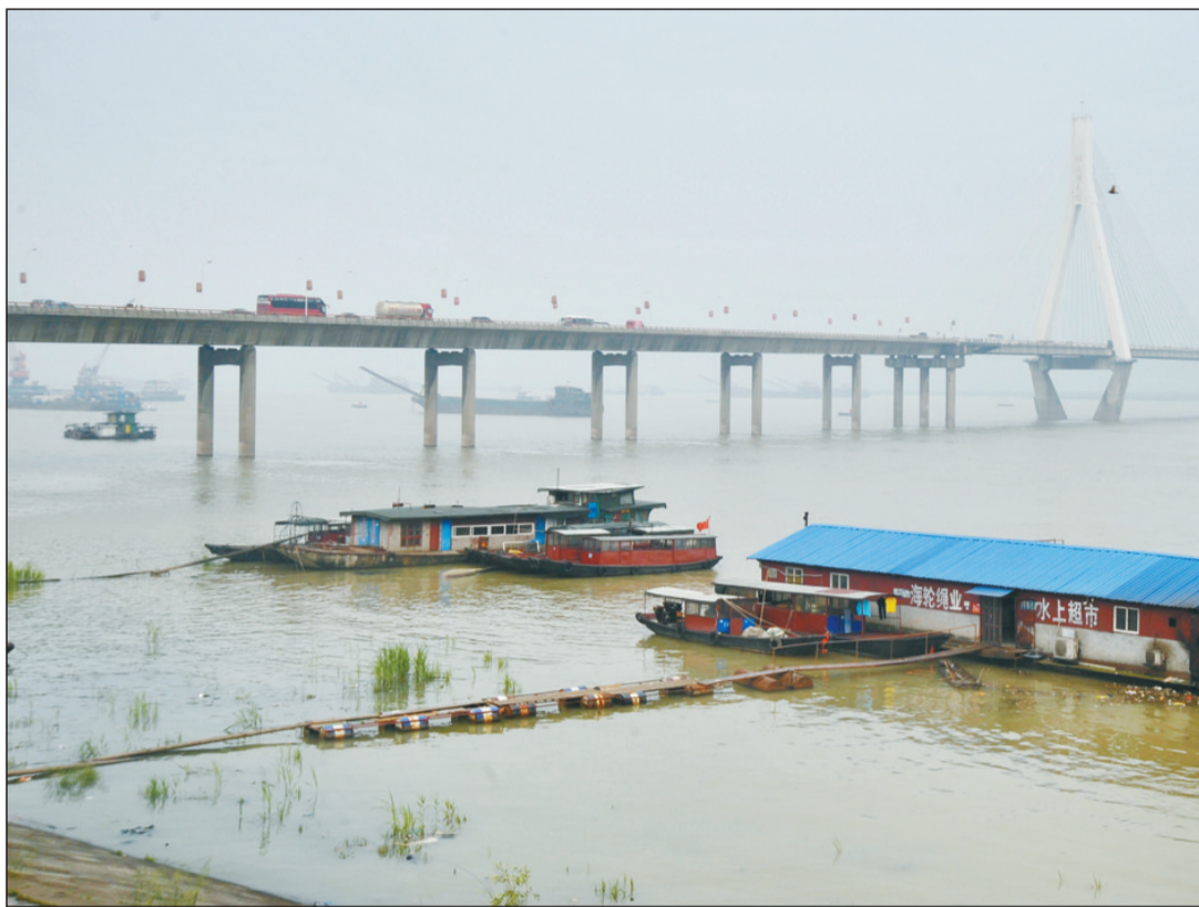
连日来,受持续强降雨和上游来水影响,洞庭湖城陵矶水位继续持续上涨。湖南省水利厅信息中心监测数据显示,截至4月28日8时,洞庭湖城陵矶水位已上涨至28.91米,逼近32.5米警戒水位。图为4月28日拍摄的高水位下的岳阳洞庭湖大桥。
