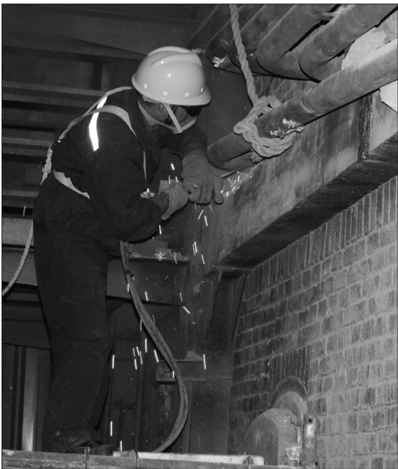
济南市今年 10 月底前,要全部淘汰(改造)城市建成区 35 吨/小时及以下 134 台 2117 蒸吨燃煤锅炉。截至目前,全市已完成淘汰(改造)74 台,共计 1212 蒸吨。图为济南某拆除锅炉现场。
