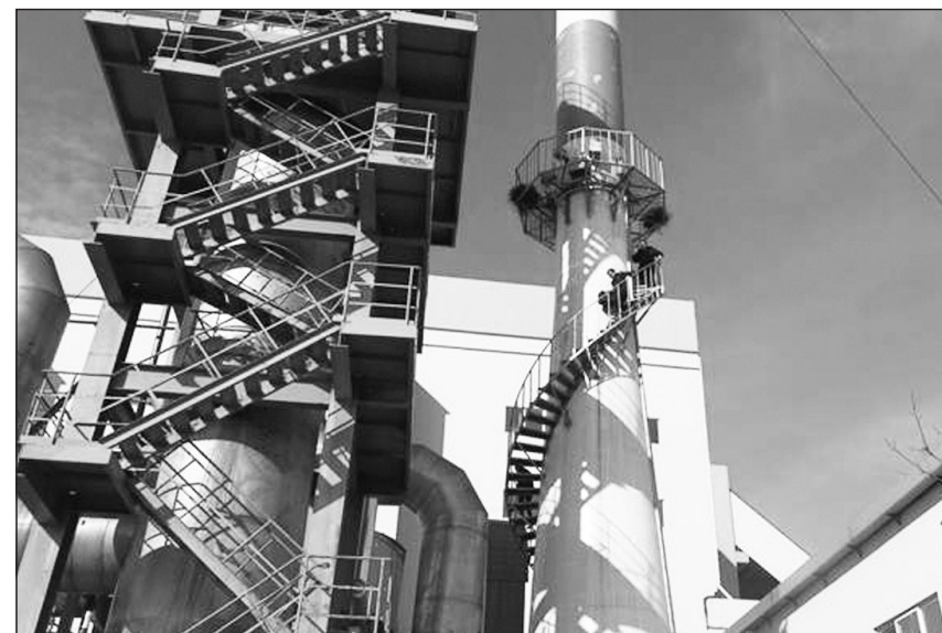
山东省胶州市环保局近日开展环境监测行动,利用全市200多个监测点,对噪声、污水、烟尘等污染物进行全方位监测。图为环境监测人员爬到近40米高的锅炉烟筒废气取样点开展监测工作。
