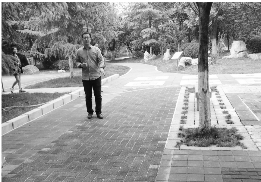
图为工作人员正在介绍铺设了透水砖的千佛山南路11号院。 王学鹏摄
