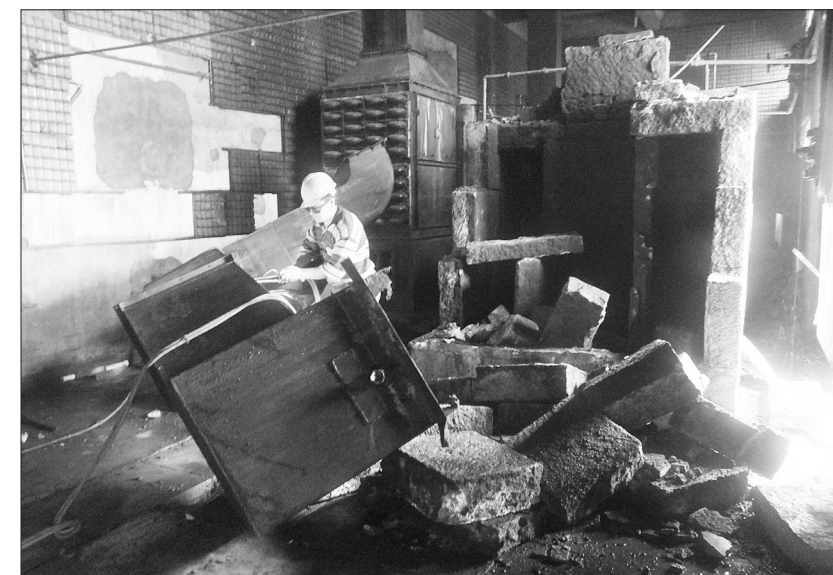
图为工人在对燃煤锅炉进行拆除。 王新胜 王文硕摄
