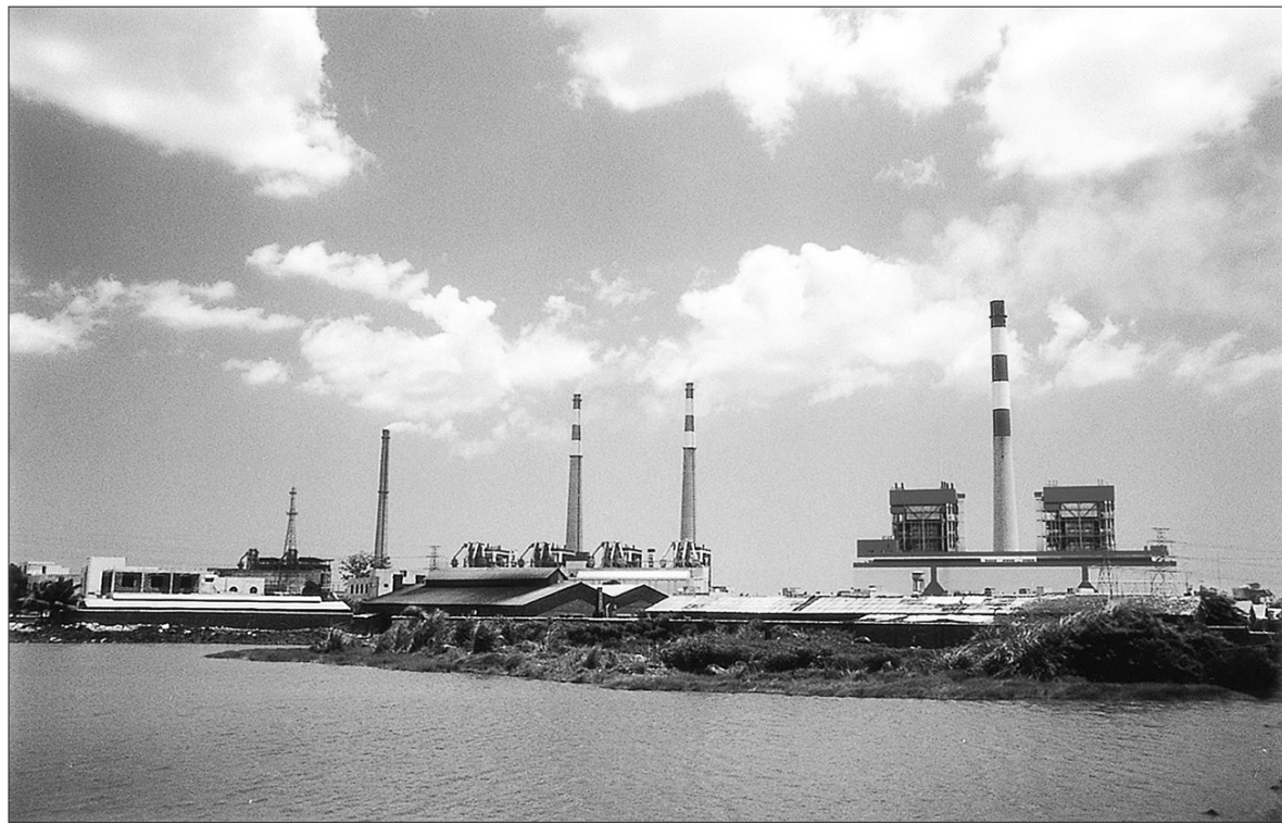
海南大力推进燃煤电厂超低排放和节能改造,积极防治大气污染。图为新兴工业厂区掠影。 孙秀英摄
