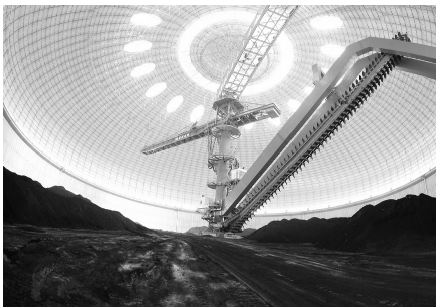
莱芜市近年来为治理扬尘污染,要求辖区内18家重点企业料场、堆场采取密闭措施。图为已经完成封闭的莱芜电厂球型煤仓。尚绪增摄
