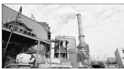
图为欣创公司三铁链磨机回转窑脱硝项目。
