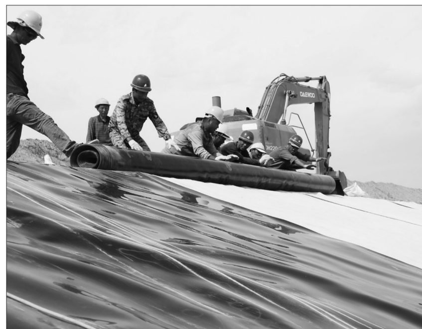
新疆兵团八十三团首个环保垃圾填埋场建设日前开始铺设土工布和防渗膜,整个工程将在10月底竣工。据悉,这一垃圾填埋场投入使用后,将对加快生态园建设、保护环境发挥积极作用。
