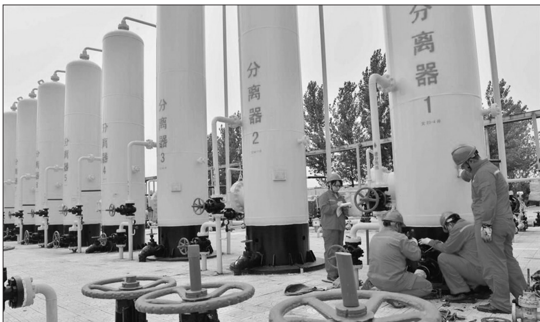
中国石化中原油田文23气田将向天然气储备转型,建成文23储气库,目前先导工程已开工建设,届时将为我国能源储备、气源调峰发挥重大战略作用。中国日报图片网
