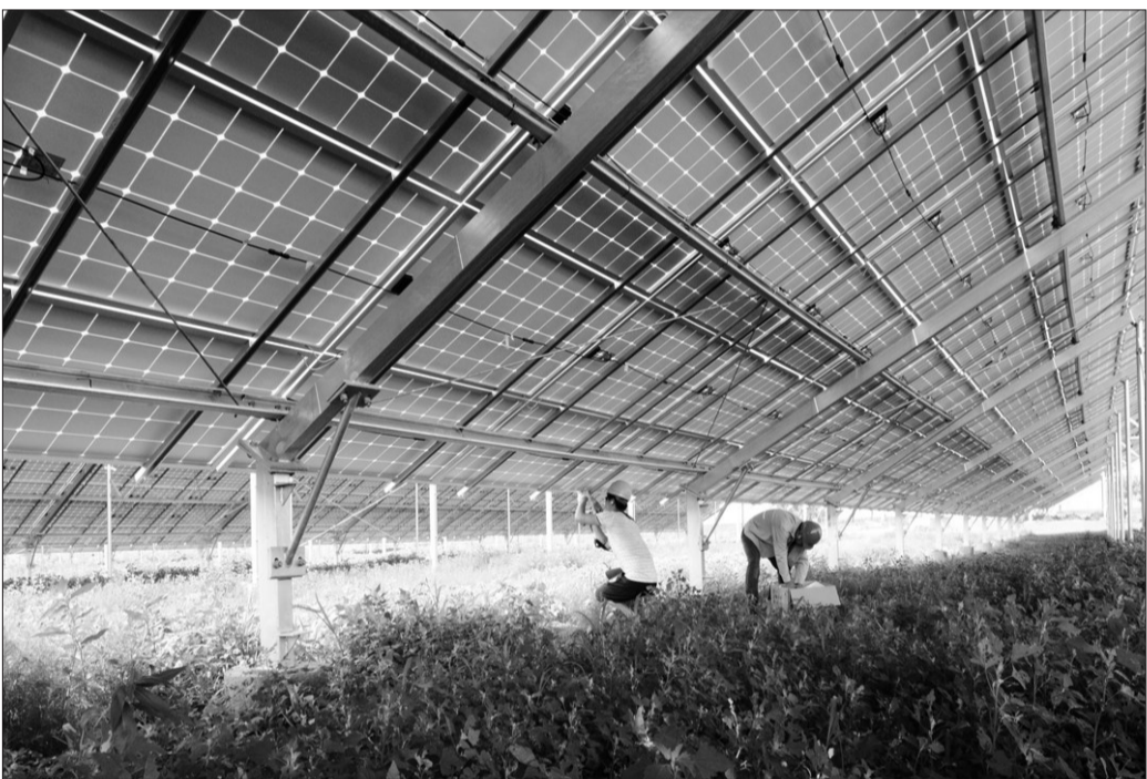
总装机容量两万千瓦的辽宁省首个“农光互补”型光伏电站,省级绿色能源示范项目又具高台子乡光伏电站日发电量1.2万千瓦的一期工程近日并网发电。电站占地827亩,将高效农业与光伏发电相结合,实现了“板上发电,板下种田”农光互补。李铁成摄
