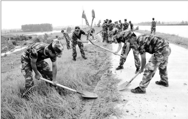
安徽省庐江县同大镇青阳村白石天河十大圩段急需防渗导渗加固,中国人民武装警察8690部队100多名官兵接到任务后,迅速运装沙石、土方上百吨加固护堤,官兵们仅用一天时间就顺利完成了3公里圩堤加固护堤任务。
