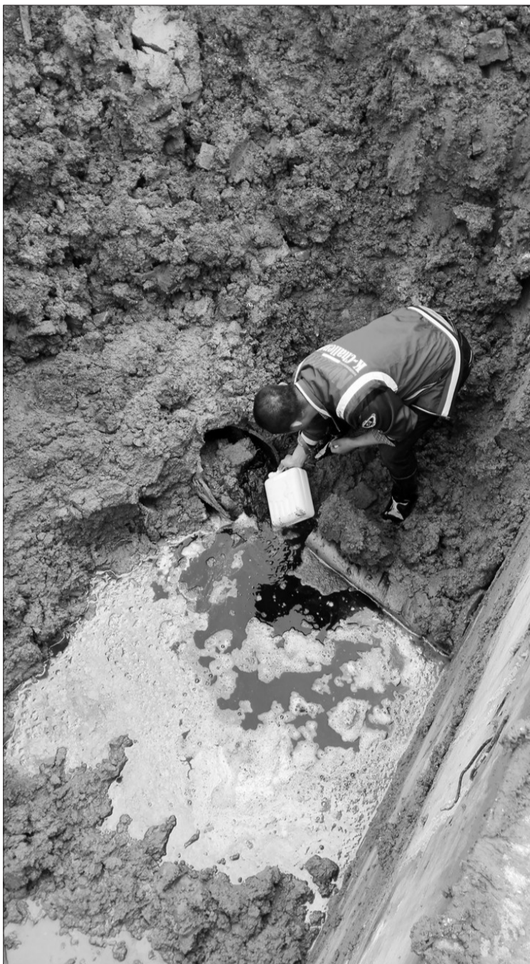
环境执法人员调查挖掘机才找到偷排垃圾渗滤液的暗管。图为环境监测人员对挖出的暗管所排污水进行采样。 欧中浩供图
