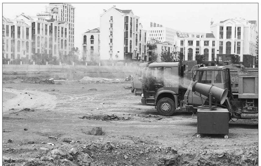
山东省青岛市高新区针对建筑工地扬尘启动“蓝天计划”,引入多功能雾炮机等科技手段加强扬尘治理。图为工地上的抑尘雾炮机。 孙俊杰 刘喜悦摄
