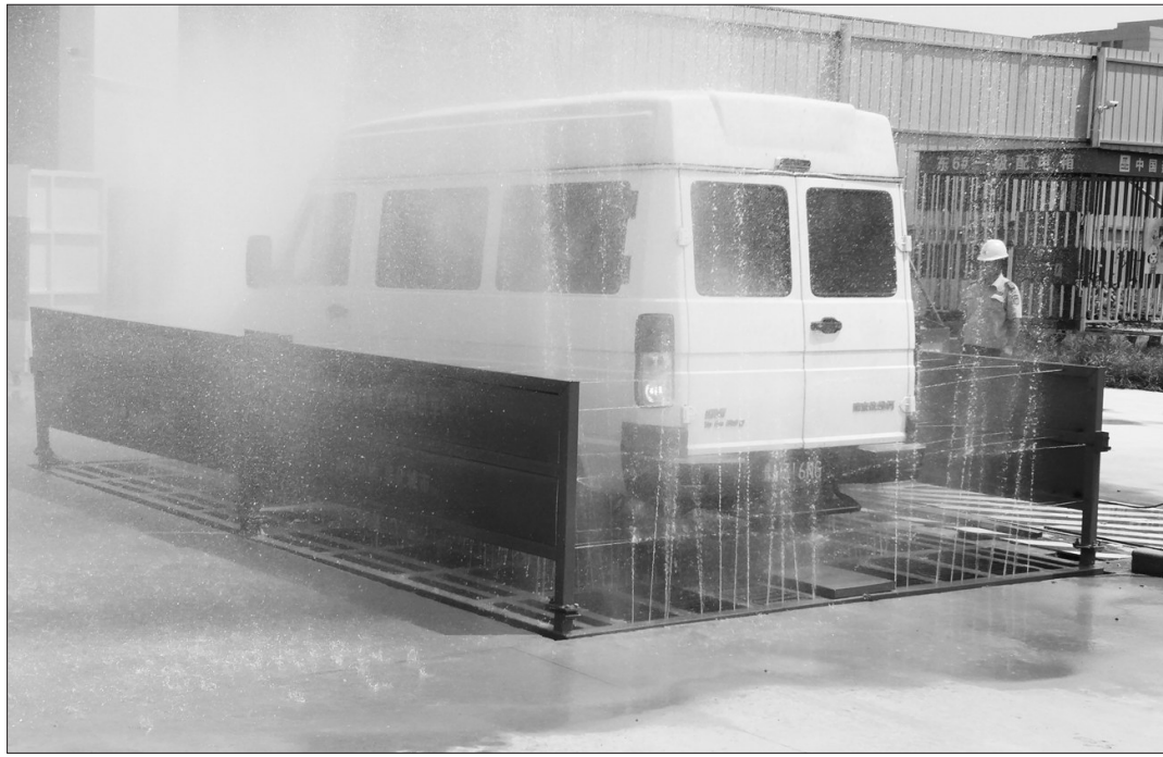
车辆在工地内喷洗除尘。 孙浩摄
