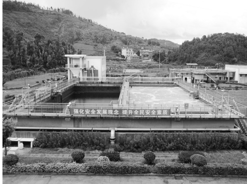
云南省文山州丘北县城镇污水处理2010年12月底建成投运,污水处理能力为0.6万吨/日,目前运行正常。 蒋朝晖摄
