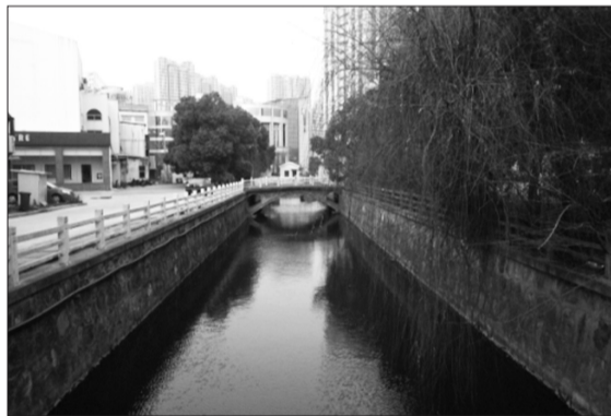
图6 城市中度污染缓流水体净化技术示范工程东桥河河道
