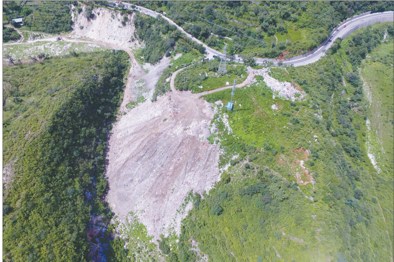
北京市房山将军坨景区垃圾预计3周内清运完毕。房山区河北镇镇长程凤航介绍,由于镇域内处理垃圾能力有限,且没有符合垃圾集中填埋场条件的建设地点,因此在檀木港村北建立了这个垃圾临时存放点,目前还有存垃圾约3万吨。
