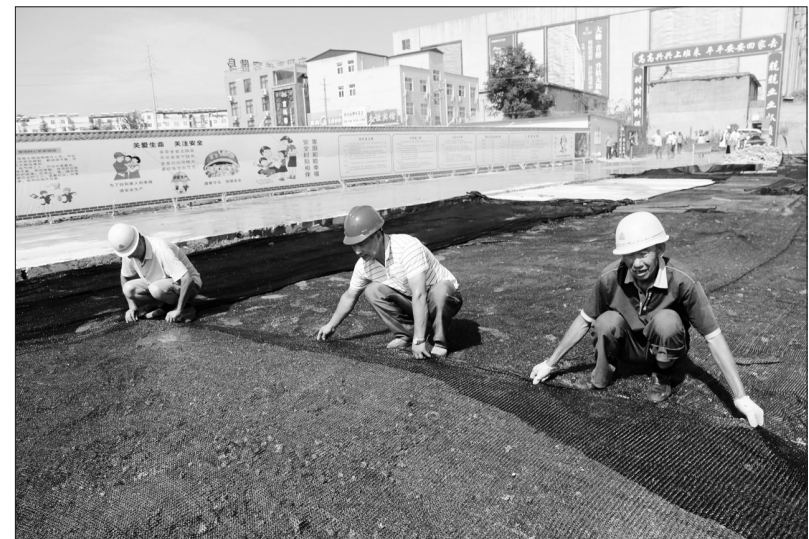
河南省宝丰县大力实施蓝天工程,多项措施防治大气污染,严格按照“六个100%”要求,加强在建28项建筑工程和22项市政工程的扬尘污染治理工作。图为施工人员对裸露的地标实施防尘网覆盖,确保施工期间尘土不飞扬。
